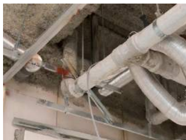
ダクト保温工事
