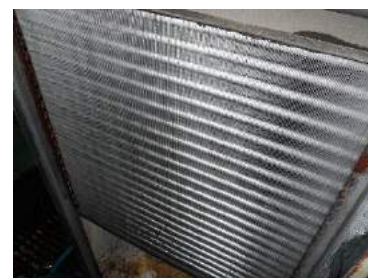
洗浄が完了したアルミフィン
