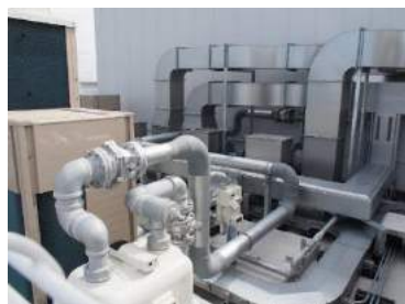
新規空調機器 ダクト設計・施工
