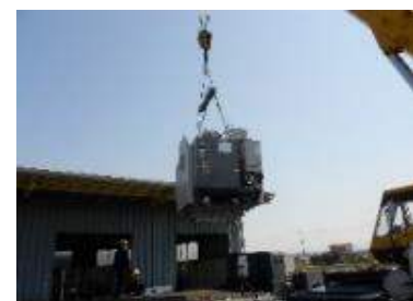
マシニングセンターの移設
